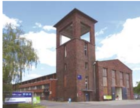
Südbloc-Boulderhalle in Mariendorf
